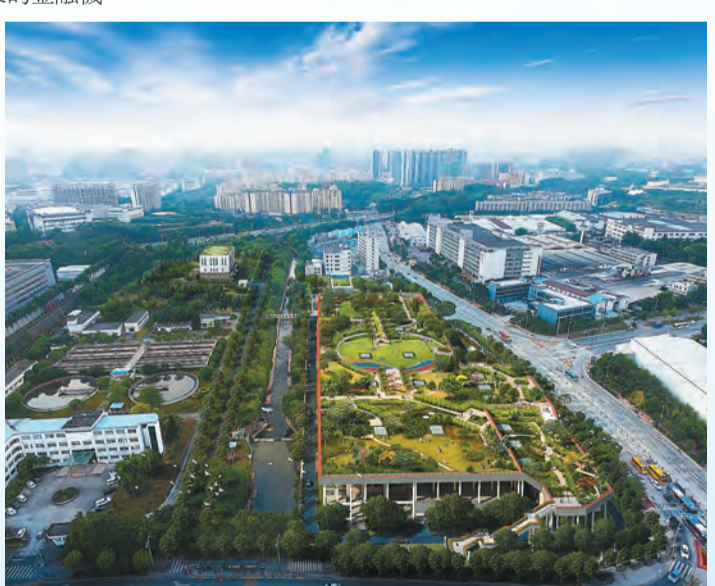
農發行深圳市分行支持的坂雪崗水質淨化廠二期工程項目
