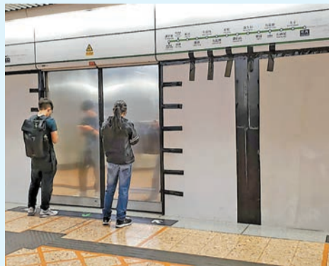
港鐵在月台裝上鋼板。
