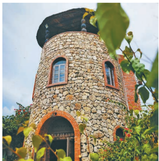
利用當地珊瑚石砌成的燈塔圖書館及民宿。圖為放坡村村民收入逐年增加。
