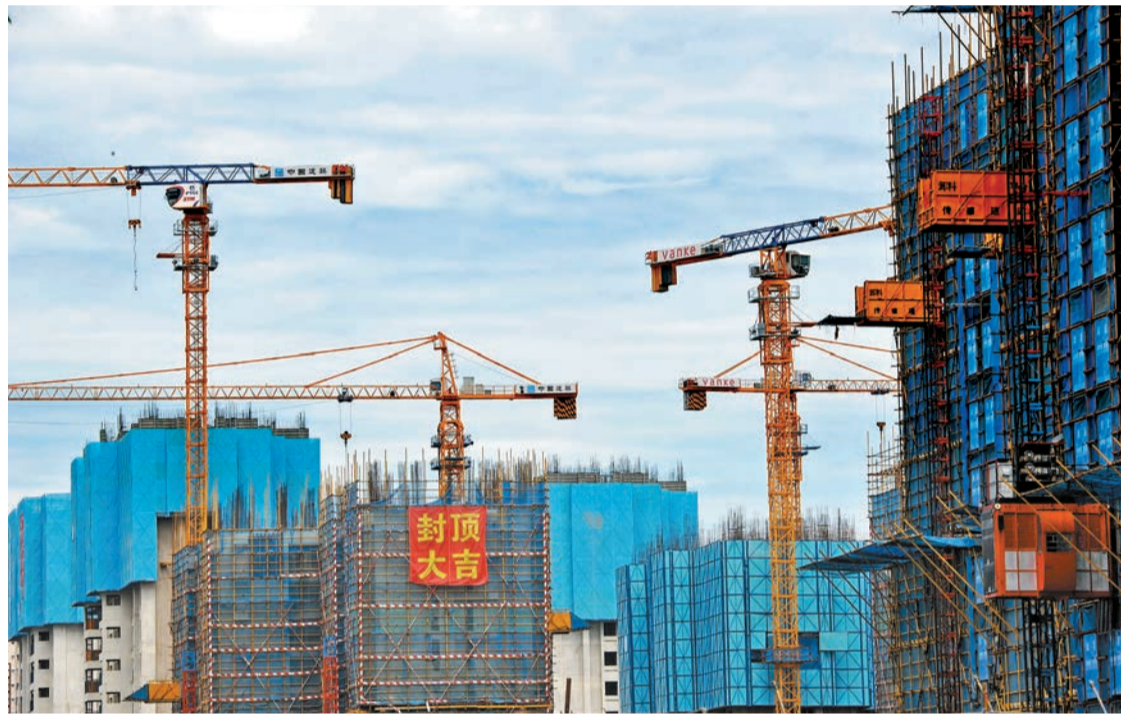
福建福州一處正在開發建設中的房地產樓盤。 中新社
