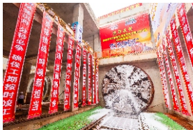
▲ 佛山市轨道交通三号线工程3201标双线隧道贯通由盾构机完成施工。 摄影：林安迪
