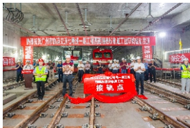
▲ 广州市轨道交通七号线一期工程西延顺德段轨道工程双线短轨贯通。摄影：林安迪
