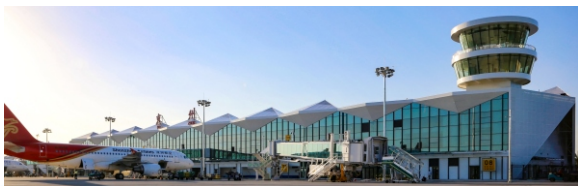
▲惠州机场T2航站楼
