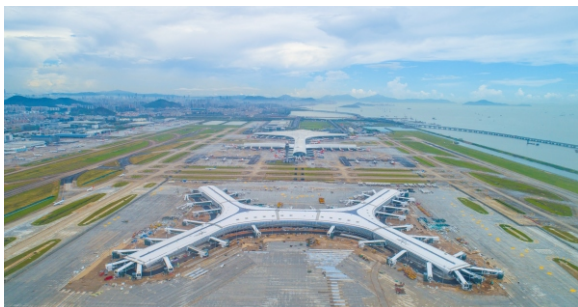
▲ 深圳机场卫星厅已完成主体工程，正在开展室内精装修，预计年内投用。
