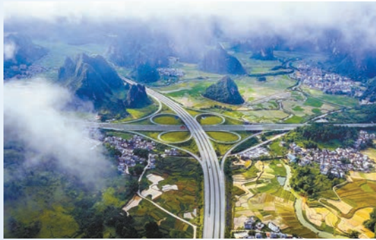
農行廣西分行支持田西高速公路建設。
