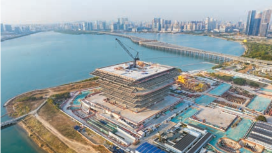
建設中的前海博物館。
